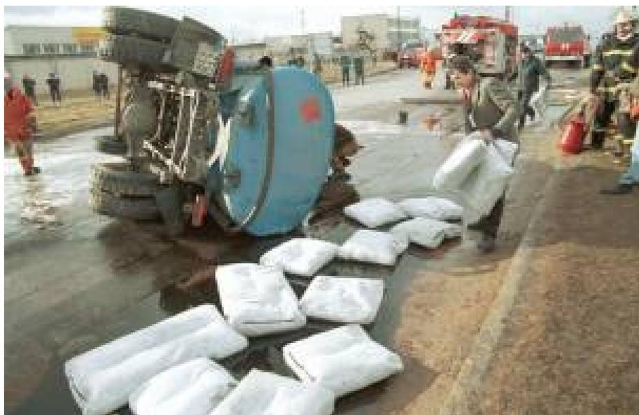
**Рисунок 12. Ликвидация с помощью УСВР аварийного пролива ГСМ, г Шауляй, Литва. Все пожарные машины оснащены специальными подушками наполненными УСВР.**
