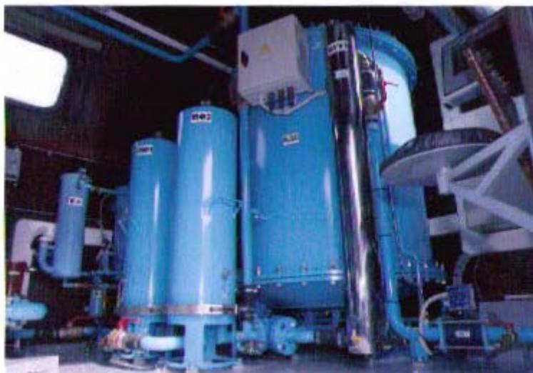
Рисунок 1 - Внешний вид блоков ультраfiltrации и сорбционного блока станции комплексной очистки воды SKO-10
